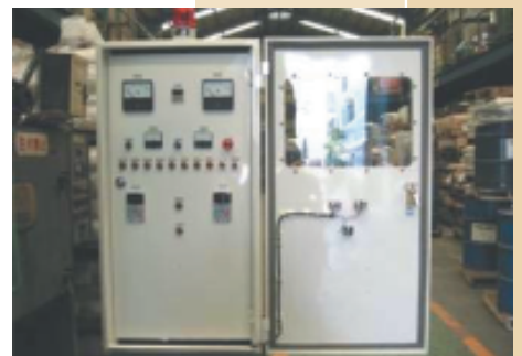
鎂合金噴砂設備防爆電控箱設計
